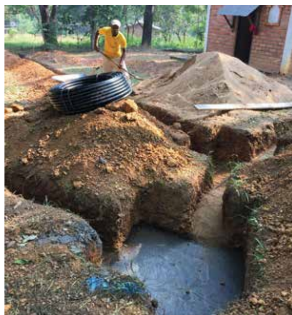
Installation du tuyau et d'un regard
