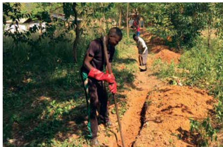
Tranchée longue de 600m
