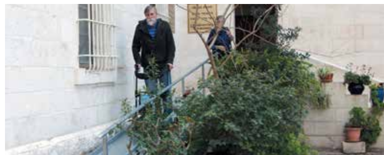
rampe d'accès à la chapelle de la Communauté à Emmaüs – Israël
